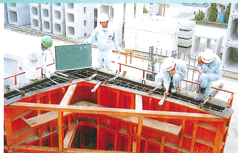
型枠・鉄筋
